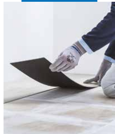
Posa di LVT adesivizzato su superficie in ceramica regolarizzata con Planiprep 4 LVT
