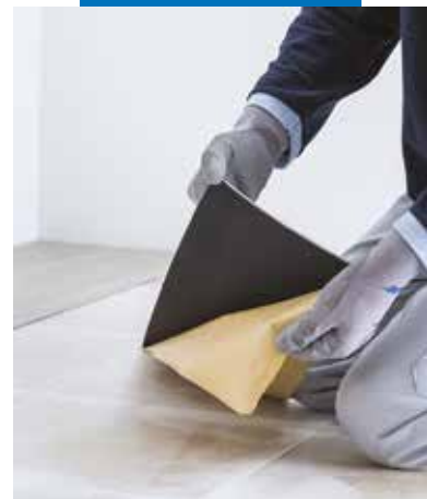
Rimozione del liner protettivo dal retro di un LVT adesivizzato
